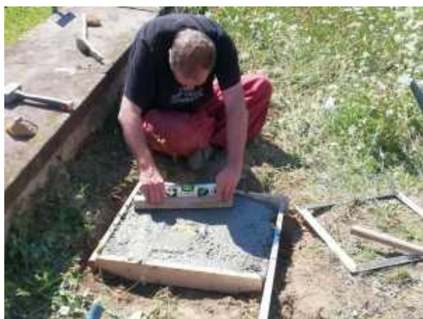
Construction d'une borne
